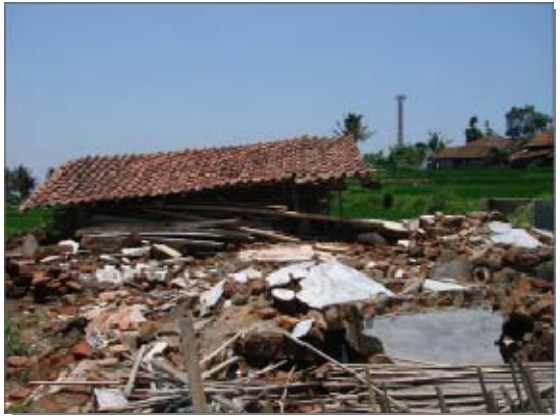
Rumah yang rusak berat di Tasikmalaya.
